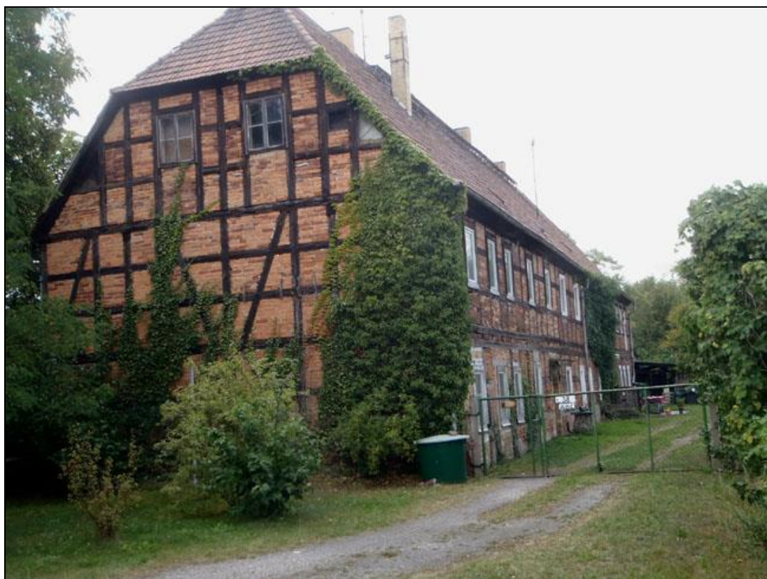
Der Blick über ´n Gartenzaun zeigt uns auch die Länge des „Langen Hauses“. Auch dieses Gebäude wird heute als Wohnhaus genutzt ( Privatgelände! )
