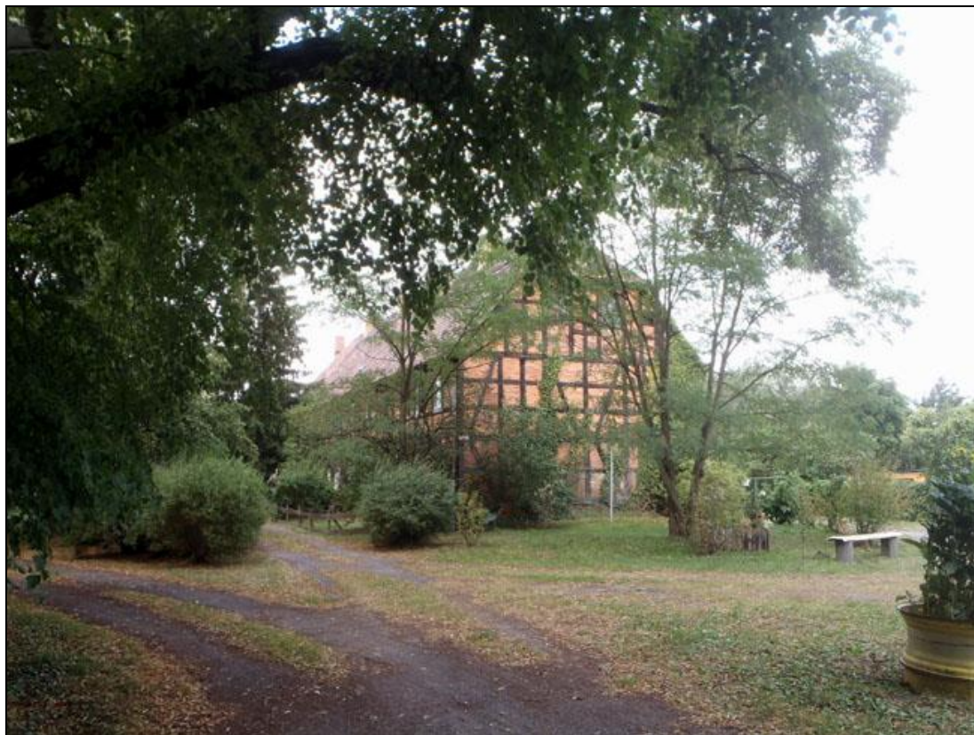
Am Ende der Straße erreichen wir eine Wendeschleife und hier finden wir auch das „Lange Haus“: Der Fachwerkbau mit der Ziegel-Ausfachung fällt zwischen den jüngeren Nachbargebäuden auf.
